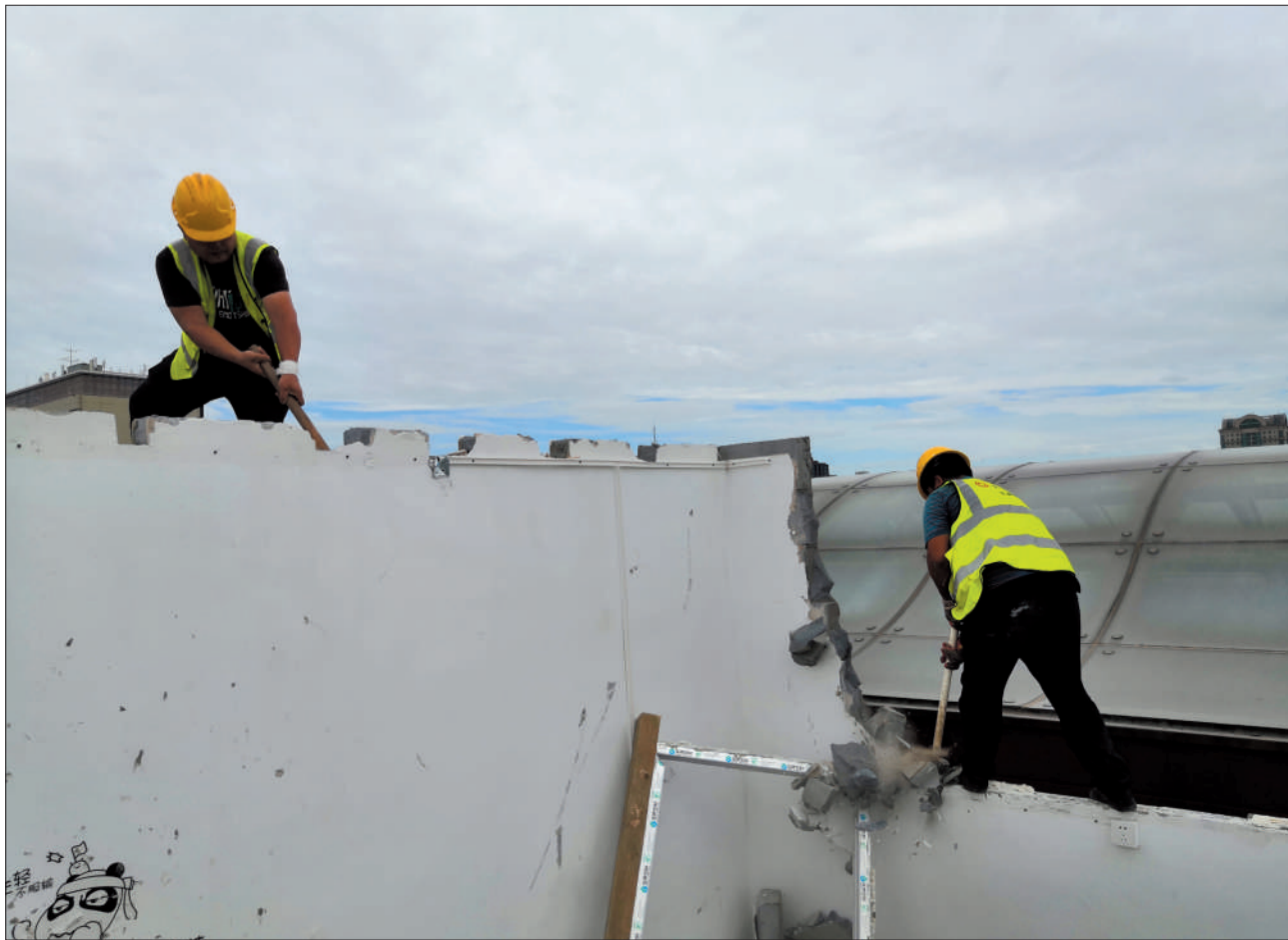
工人正在拆除违建。
